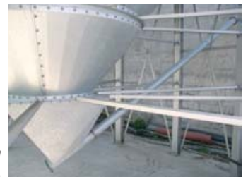
Kraftig infästning av ben i silon.
